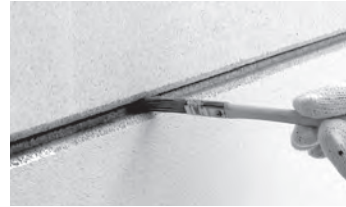
プライマーの塗布
