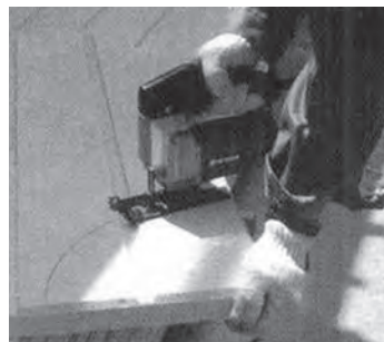
曲線切断(電気ジグソー)
